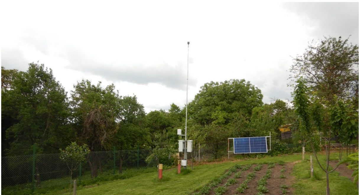
Obr. 100. Klimatická stanica inštalovaná v severnej časti zosuvného územia Nižná Myšľa.
